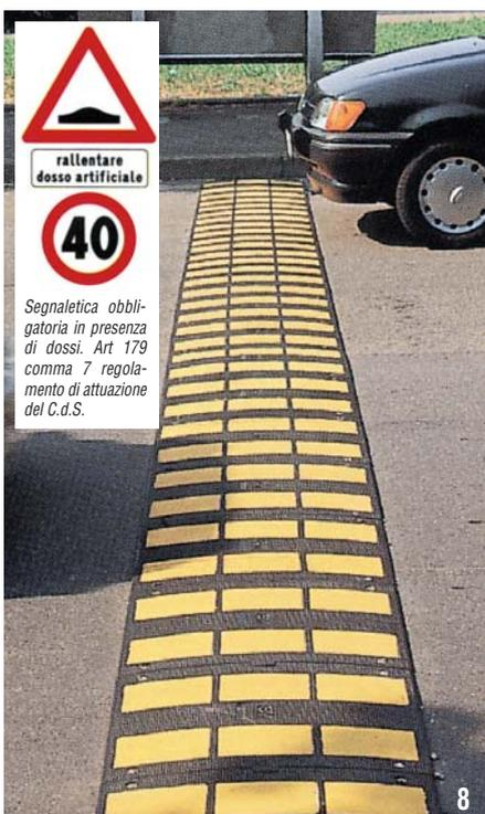
**8 DOSSI ARTIFICIALI** Elementi modulari in gomma naturale evidenziati mediante zebraure gialle e nere parallele alla direzione di marcia. Gli inserti gialli sono in laminato elastoplastico ad elevata rifrangenza ed antiscivolosità. Ogni singolo modulo è installabile con un sistema di fissaggio mediante tasselli ad espansione (compresi nella fornitura). Conformi alle specifiche del Regolamento di Esecuzione e di Attuazione del nuovo Codice della Strada (DPR 16.12.1992 n. 495, art. 179).
